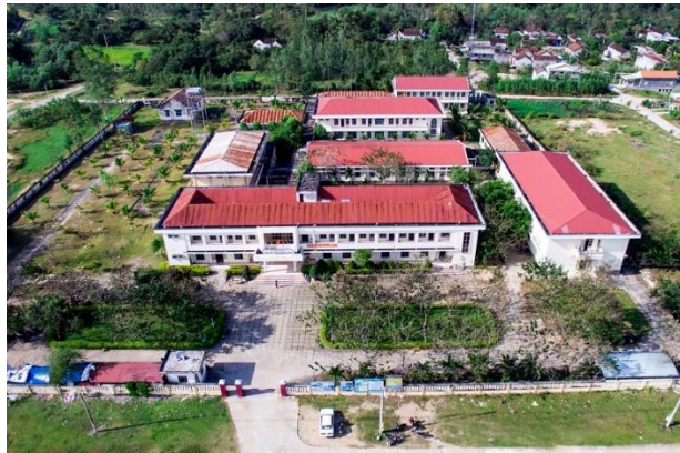
Hình 4 - Hiện trạng công trình y tế trên địa bàn huyện Vĩnh Thạnh
